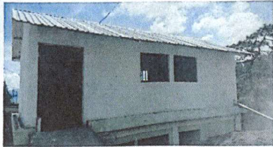
Foto1: Finalización del cambio de techo
