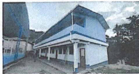
Foto 4: Finalización de canaletas y tubos de agua fluvial
