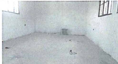
Foto 6: Finalización de piso adentro y afuera terminado
