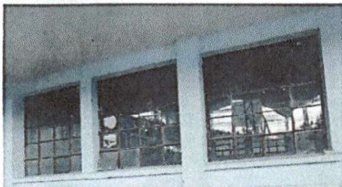
Foto 3: Finalización de cambio de vidrios de las aulas
